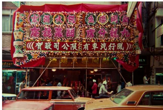
1974 尖沙咀麼地道店 Mody Road, Tsimshatsui
